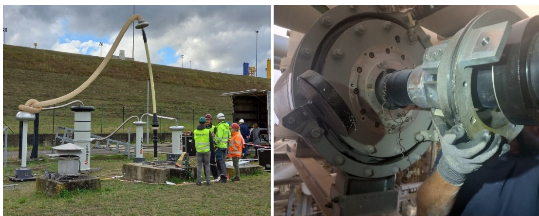
Obr.1 Diagnostické meranie káblového súboru – fáza L1 s dočasnou koncovkou, poškodená káblová koncovka v R400kV VE Gabčíkovo
