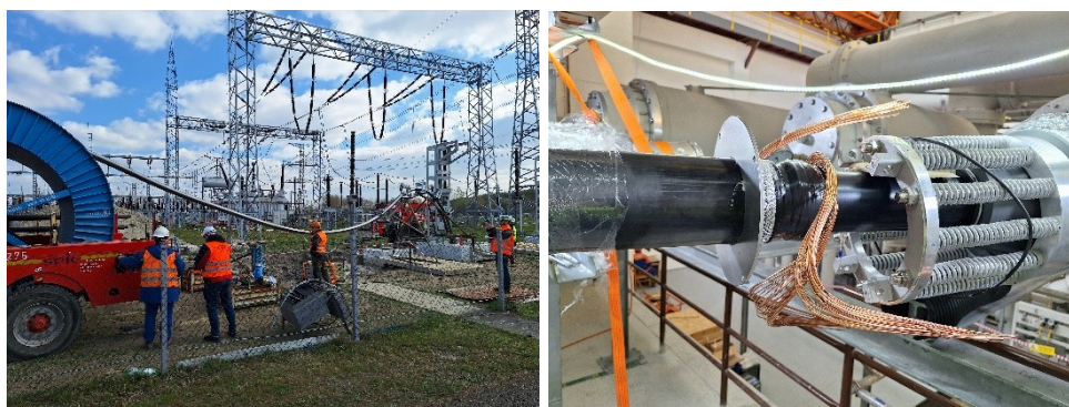
Obr.3 Záťah 400kV kábla a detail montáže vnútornej kábovej koncovky
